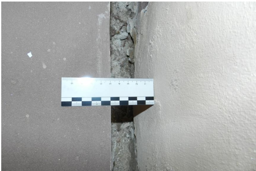
Aufgestemmter Anschluss Boden/Innenwand, Foto: AN
